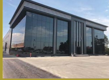
Kayalar Mutfak Üretim Tesisi Güzelce / İSTANBUL
